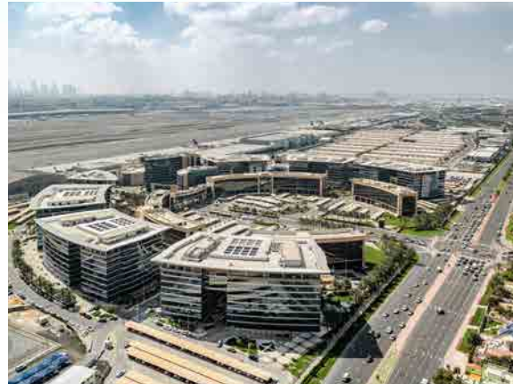
現地法人「NSK Middle East FZCO」オフィスが入居するドバイエアポートフリーゾーン
