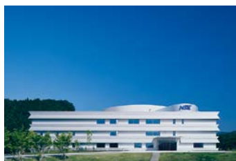
本社棟(RD1棟)
