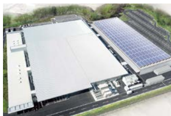
太陽光パネル(A1+棟)
