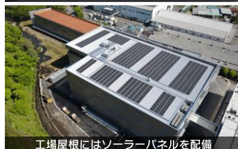
工場屋根にはソーラーパネルを配備
