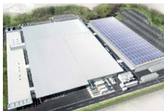
太陽光パネル(A1+棟)
